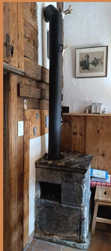
Maison les Chevriers, Vissoie: fourneau de 1892 avec conduite de fumée moderne
